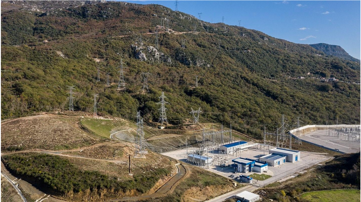
Slika 2. Trafostanica 400/110/35 kV Lastva Grbaljska
