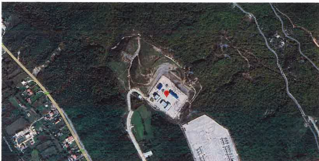
Slika 1: Pozicija transformatorske stanice
